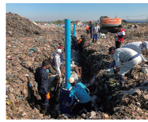
海外で福岡方式を利用して埋立場をつくる様子
